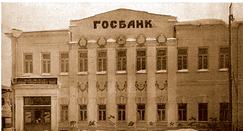
Здание Госбанка. 1922 год.
